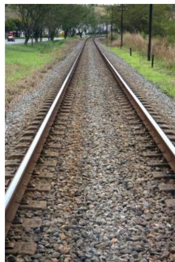
Ramal de São Paulo: A primeira via férrea da América do Sul com dormentes de concreto, fixações elásticas e trilhos longos soldados.
